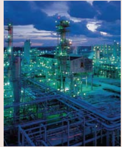
Bontang LNG Terminal, VICO
